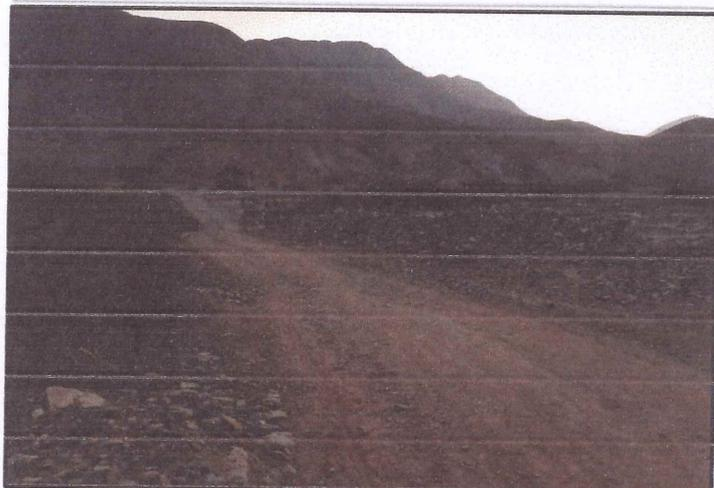
FOTO N°02: Se puede apreciar el estado de la superficie de rodadura entre el Km 06+000 – Km 07+000
