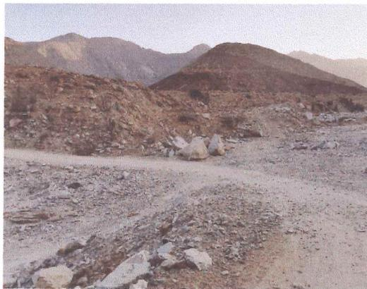
FOTO N°01: En la fotografía se muestra el baden de terreno natural en regular estado ubicado en la progresiva 0+850.00
