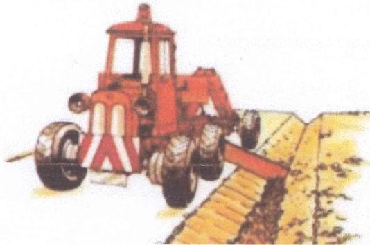
La siguiente pasada limpia el talud exterior y saca el material en el borde superior de la cuneta.
