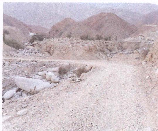
FOTO N°02: En la fotografía se muestra el baden de terreno natural en regular estado ubicado en la progresiva 5+300.00
